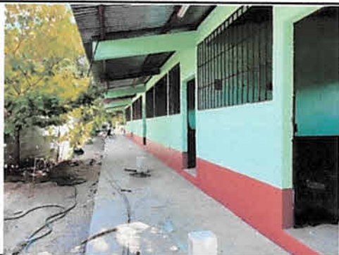
Foto 1: AULAS Sustitucion y fabricacion de ventaneria de PVC en Aulas
