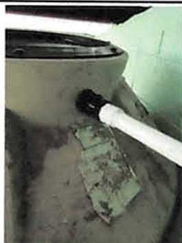
Foto 3: BAÑOS: Instalacion de tuberia de agua potable.
