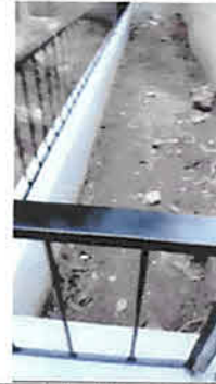
Foto 2: PATIO: Fabricacion de bordillo para jardinera y fabricacion de baranda de metal para la jardinera
