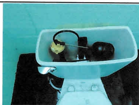
Foto 4: BAÑOS: Instalacion de tuberia de agua potable.
